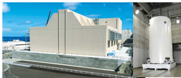
四電の乾式貯蔵施設
