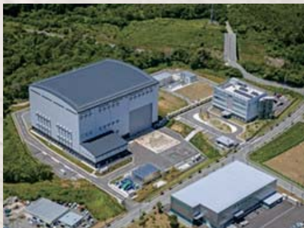
楢葉遠隔技術開発センター
