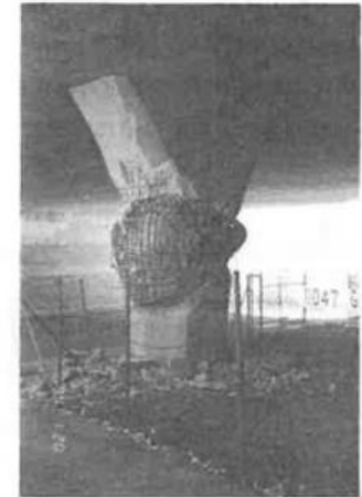
写真 5.5.29 LP3-2 橋脚の被害 (曲げせん断破壊が進み、軸線が完全にずれている) 2)
