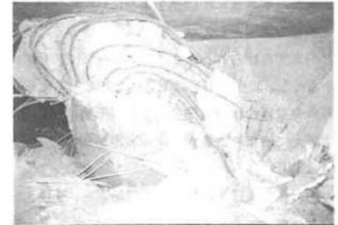
写真 5.5.27 RP3-2 橋脚の被害 (橋脚の基部が傾斜している) 2)
