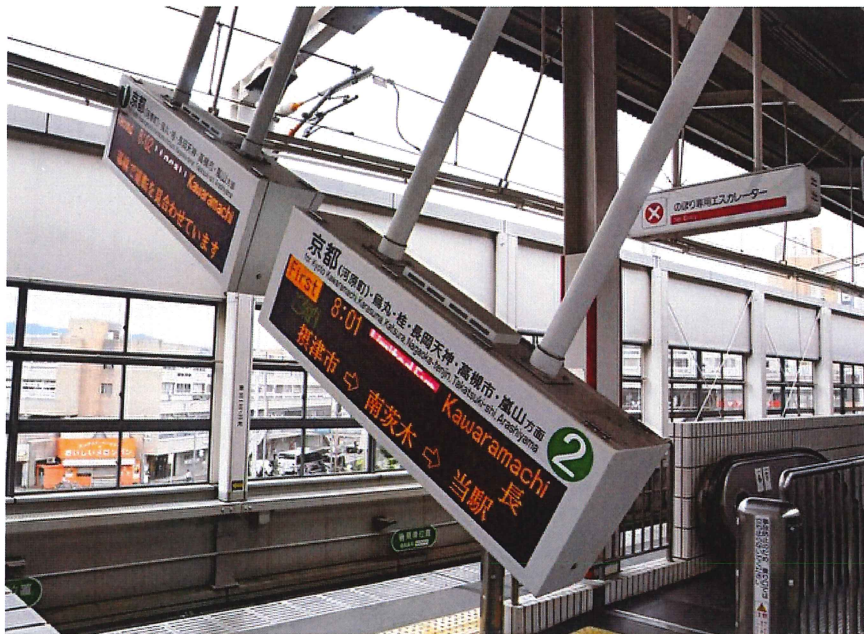
激しい揺れで落下した電光掲示板。大阪府茨木市の阪急茨木市駅（写真：読売新聞/アフロ）
