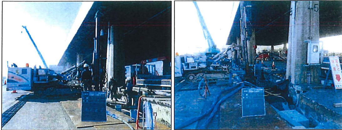
＜施工状況写真＞
