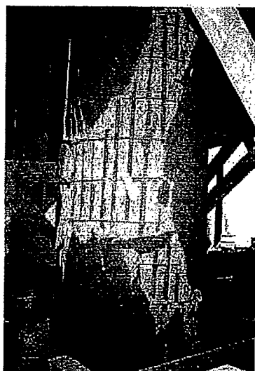
↑写真 5.5.19 復旧工事（新設の RC 橋脚の工事である。橋脚にはコンクリート養生のため、白いシートがかけられている） 1)
