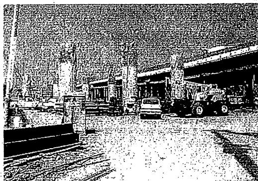
↑写真 5.5.19 復旧工事（新設の RC 橋脚の工事である。橋脚にはコンクリート養生のため、白いシートがかけられている） 1)
