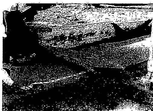
写真 5.5.53 歩道コンクリートブロックの座屈変形 (バルボア大通り) 2)
