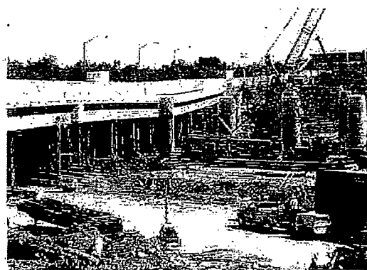
写真 5.5.33 東行き橋梁の再建工事 1)
