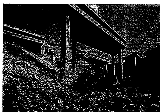
写真 5.5.11 ガビン・キャニオン橋の被害状況 (EERC による) (中央の PC 桁部の状況。南行き、北行きとも被害はなかった。橋脚にも被害は生じていなかった)
