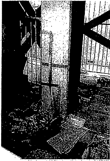
写真 5.5.45 橋脚基部の被害状況（橋脚基部が曲げせん断破壊し、大きなクラックが入っている）
