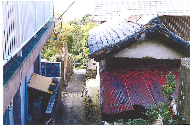
与修の集会所(右)とそこに通じる道。近くには土砂崩れ危険箇所もある。愛媛県伊方町。2015年11月2日
