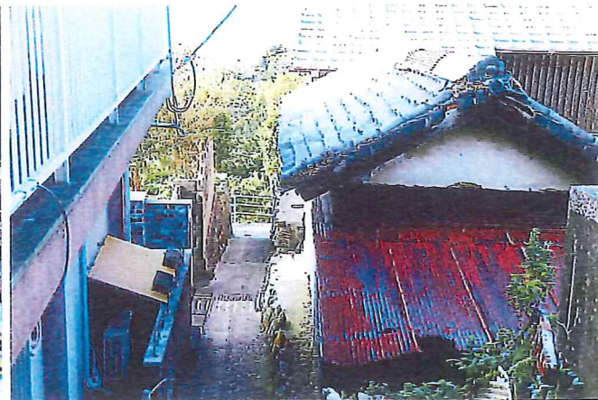
与島の集会所（右）とそこに通じる道。近くには土砂崩れ危険箇所もある。愛媛県伊方町。2015年11月2日
