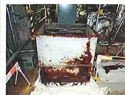
島根原発2号機で見つかった空調換気配管の腐食と穴＝2016年12月21日、松江市（中国電力提供）
