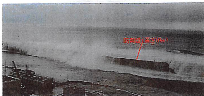
【福島第一原発 津波来襲状況 2011年3月11日 国際原子力研究所蔵蔵庫裏側より(5号機の前) 写真(1)から写真(5)まで】東京電力提供
