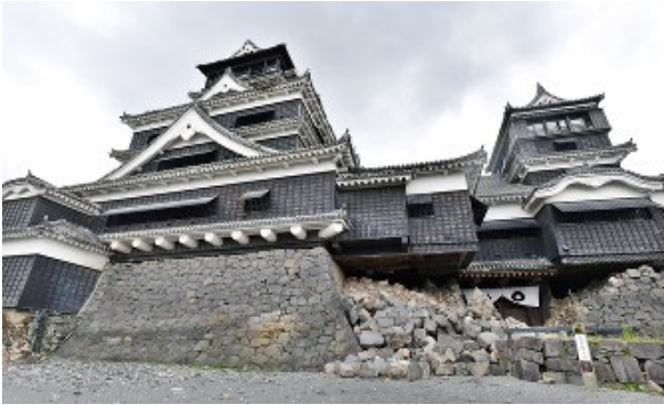
4月の熊本地震で石垣が崩れた熊本城＝熊本 本中央区で2016年5月、小関勉撮影
