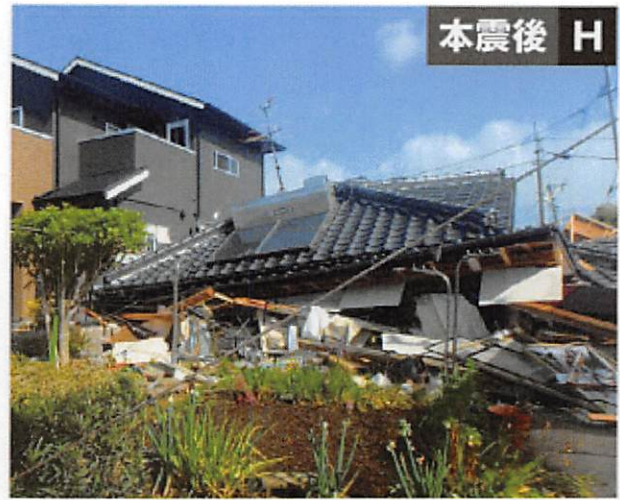
本震後のH。西側に倒壊し、隣家にぶつかっている（写真：日経ホームビルダー）
