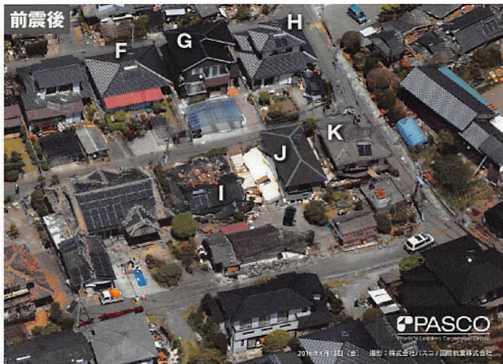
前震後の4月15日、益城町馬水地区の一角の様子。この時点で自立していたF、G、Hの住宅のうち、FとHは本震で倒壊した。I、J、Kの住宅は前震で大きな被害を受けた（写真：パスコ／国際航空）
