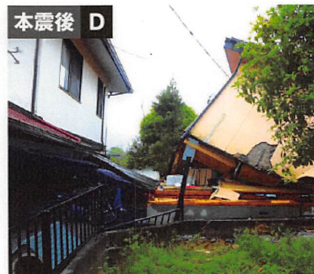
柱が引き抜け、転倒するようにして倒壊した（写真：日経ホームビルダー）
