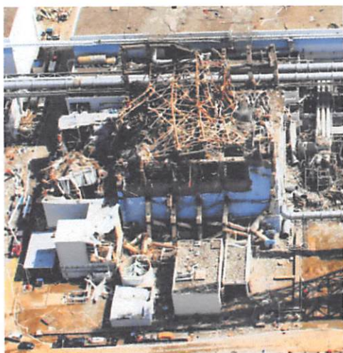
損壊した3号機原子炉建屋（3月24日、朝日新聞）
