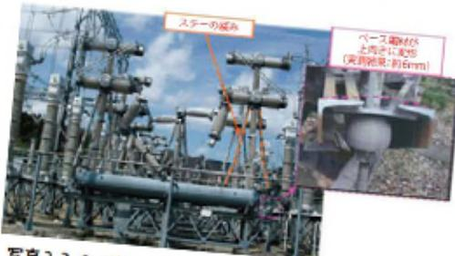
写真2.3-1 275KV空気遮断器の損傷状況(新福島変電所)<sup>2)</sup>
