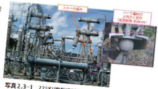
写真2.3-1 275KV空気遮断器の損傷状況(新福島変電所) 2)
