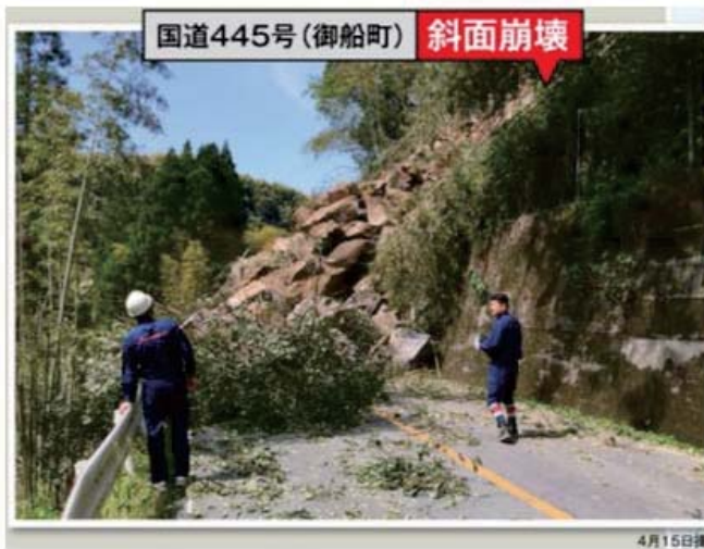
図 15 熊本地震による道路損傷の例 伊方地域集落から避難経路まで出られない
