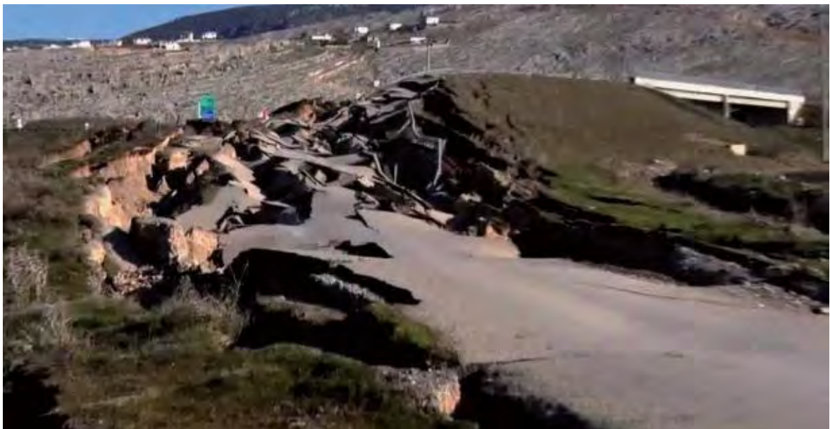
図 3 2023年2月6日発生 of トルコの地震による道路被害。中央構造線が活動した場合は同等以上の被害の可能性。
