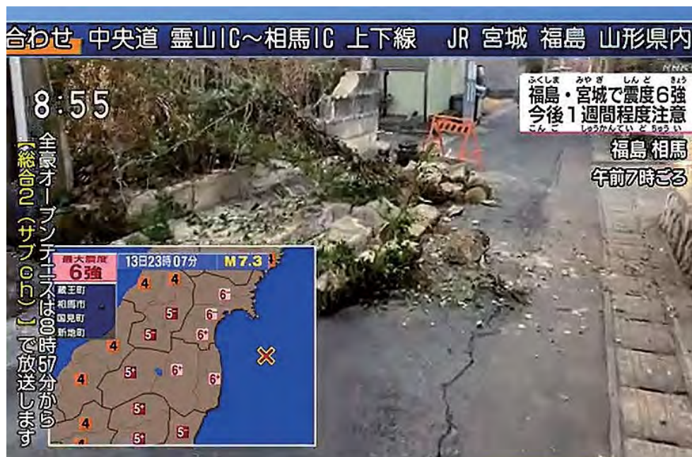
図 17 地域内のブロック塀倒壊
