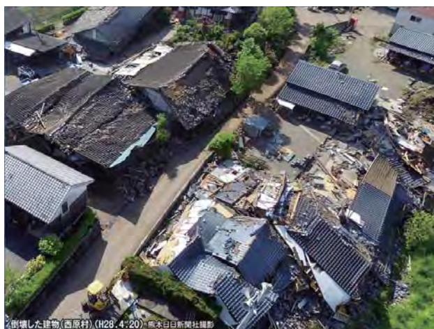
図 27 屋内退避の困難性(熊本地震の例) 建物が倒壊しなくても損傷すれば遮へい効果は失われる
