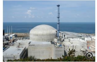
フラマンビル3号機 ©EDF
