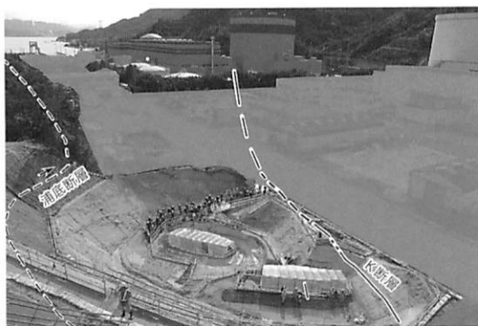
写真6—敦賀原発内の浦底断層とK断層(原子力規制庁資料による)
