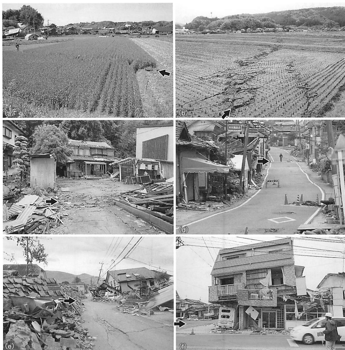
写真 1—益城町における地震断層と被害(矢印の位置に地震断層, 撮影位置は図1に示す)
