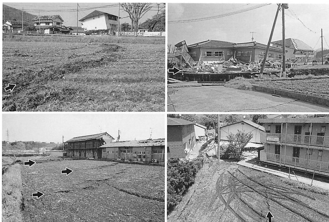
写真2—南阿蘇村河陽・黒川地区における地震断層と建物被害(矢印の位置に地震断層)
