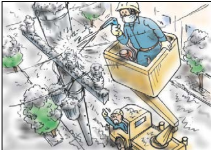
停電防止のため碍子等の清掃（降灰除去）が必要
