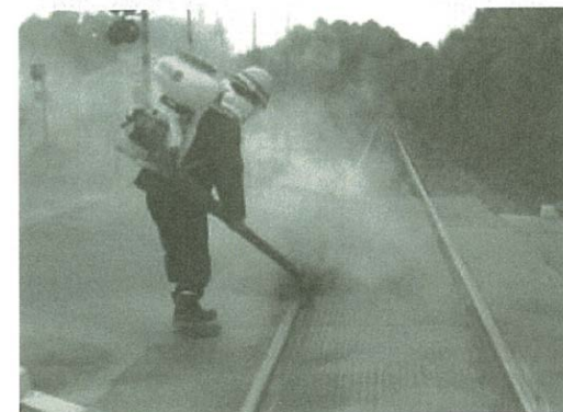
写真-6 灰の除去作業
