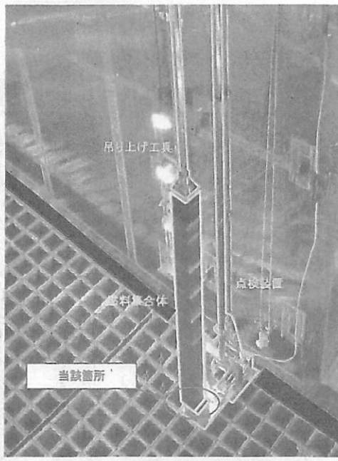
伊方原発3号機の燃料プールで点検用ラックの枠に乗り上げた燃料集合体。20日午後(四国電力提供)
