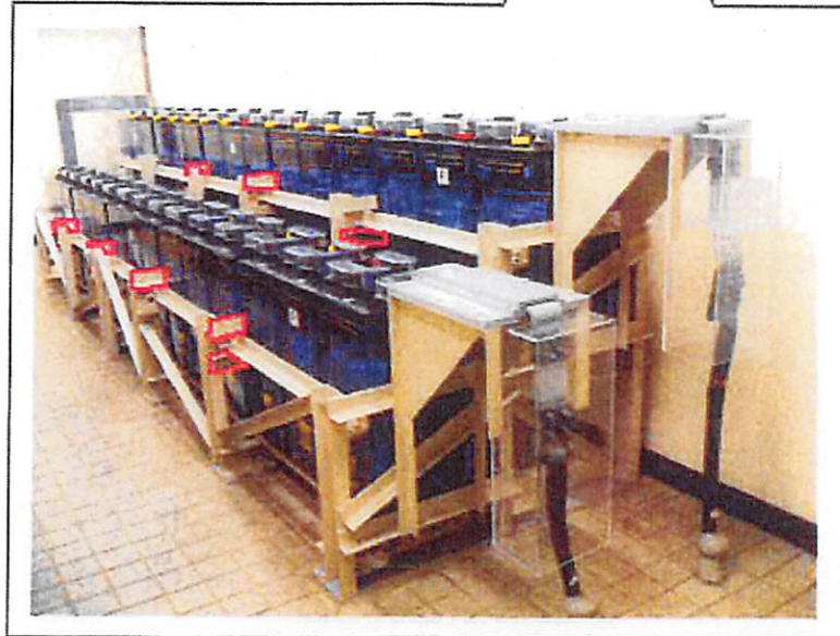
現場写真（工事後）
