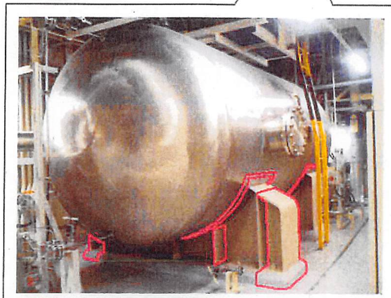
現場写真（工事後）
