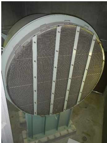
非常用ディーゼル発電機 吸気フィルタ部 (大飯3,4号機の例)
