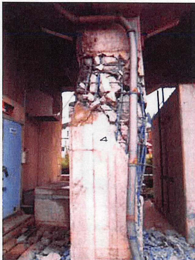
新潟県中越地震で損壊した上越新幹線の高架橋
