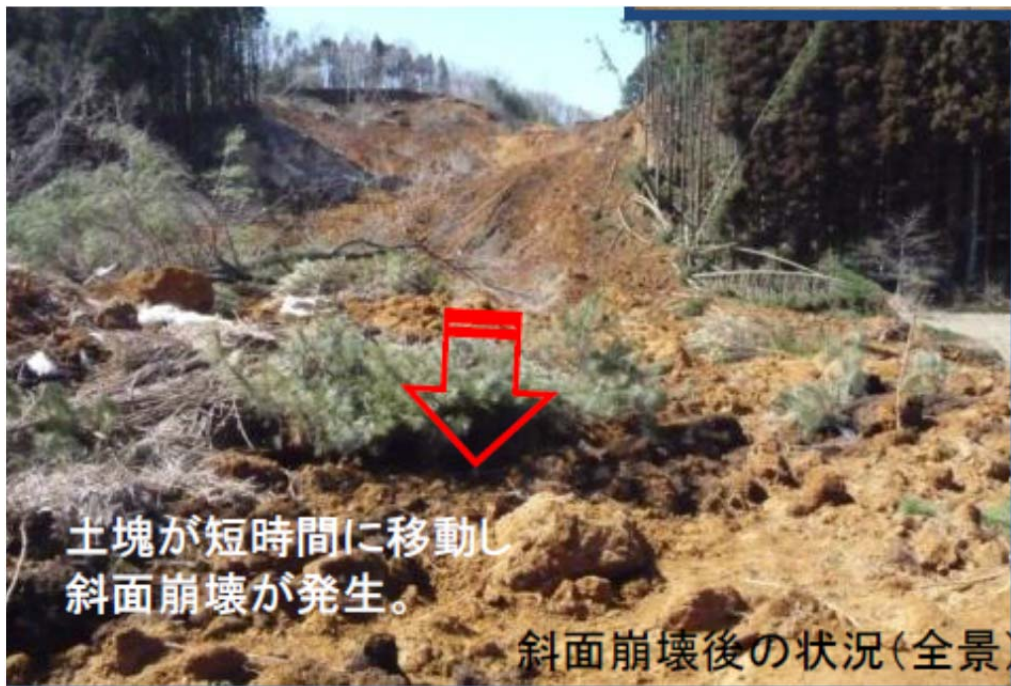
(甲 B523 ・ 2 頁 福島県での斜面崩壊の様子)
