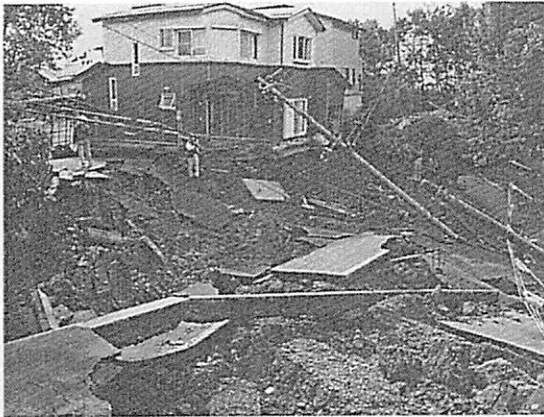
写真2 新潟県中越地震による長岡市高岡団地の被害。崩壊した部分は、谷頭部の盛土である。
