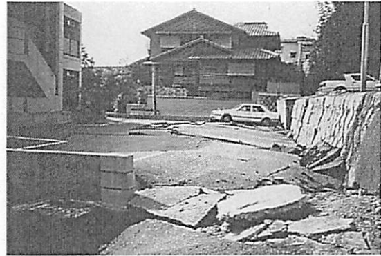
写真1 兵庫県南部地震における谷埋め盛土の地すべり(西宮市)。画面奥の民家と手前の道路の間(駐車場の部分)はかつて、深さ5m程度の谷であった。この谷埋め盛土は、画面の200mほど右から左へ数m移動し、画面左のマンションに当たって停止した。駐車場には、末端部の隆起に伴うクラックの発達が顕著である。ここは、現在では住宅地として使われている。
