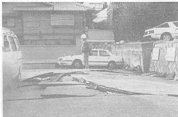
図22 地すべり地塊先端部に発達する圧縮性亀裂（兵庫県西宮市）
