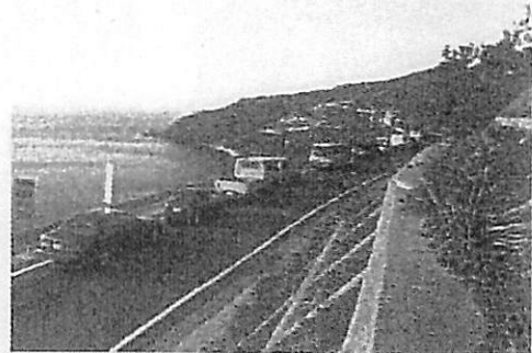
写真-3 迂回路の混雑状況
