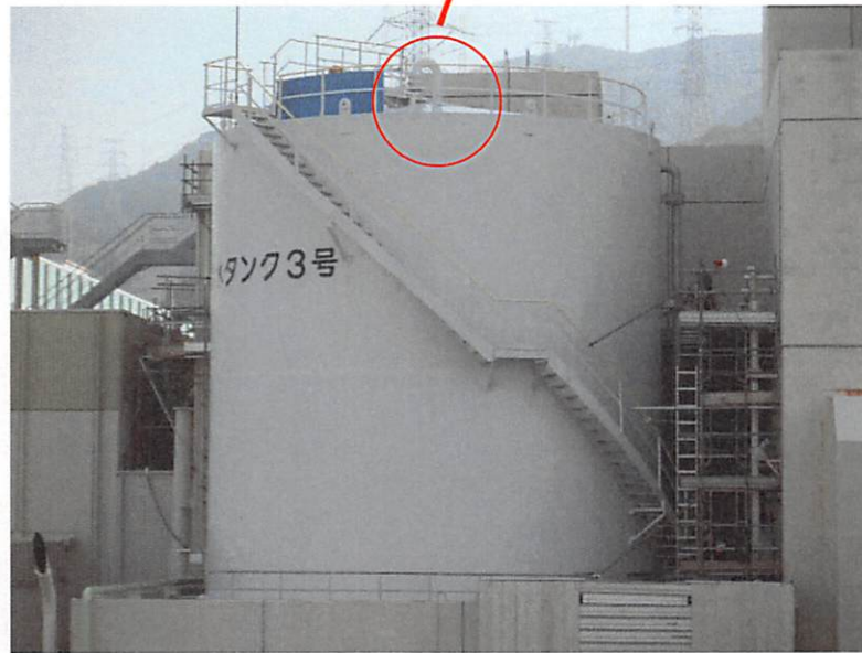
図1 3号機補助給水タンク
