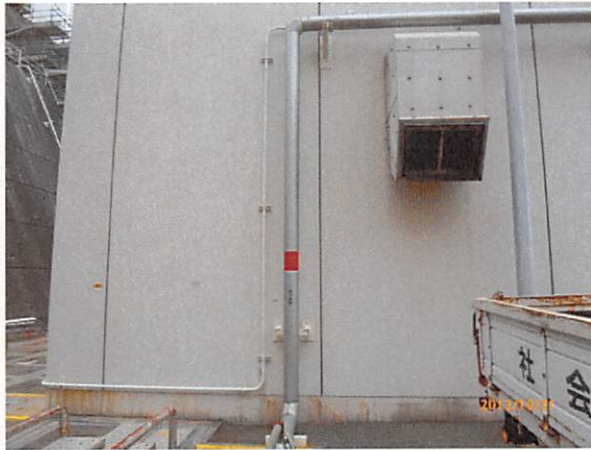
図3 ディーゼル駆動消火ポンプ排気口
