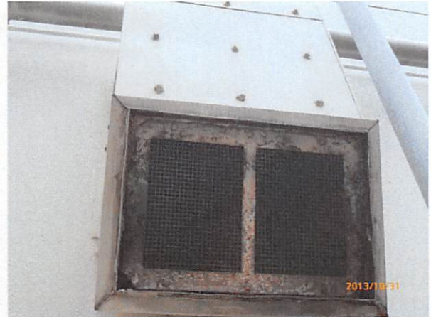
図3 ディーゼル駆動消火ポンプ排気口
