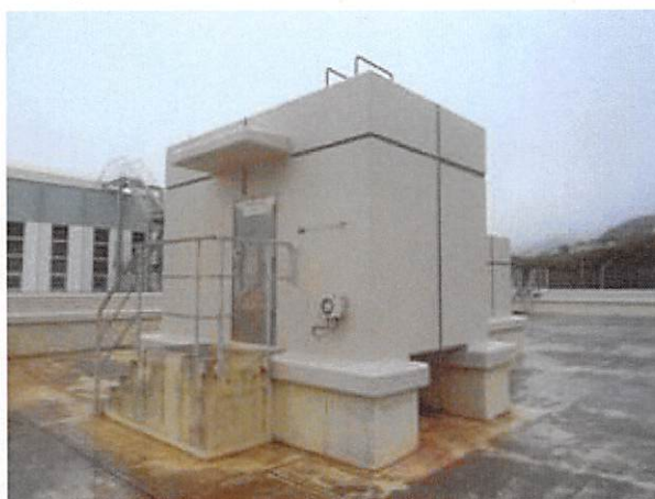
図1 外気取入口（中央制御室）
