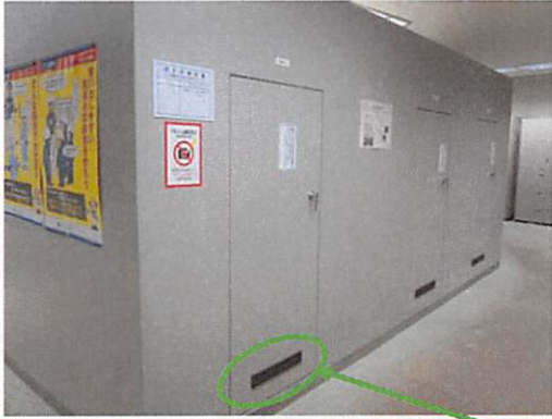
図3 原子炉補助盤 (裏面)
