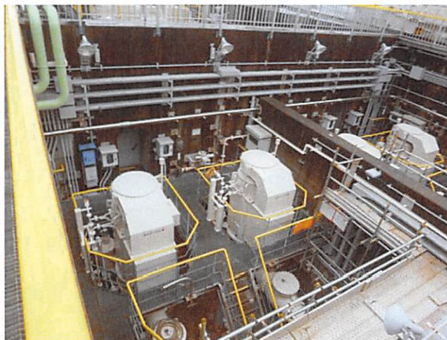
図6 海水ポンプ（モータ）
