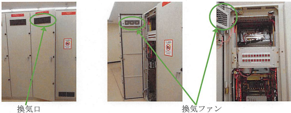
図1 安全保護系計器ラック
