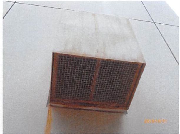
図2 純水装置建屋給気口
