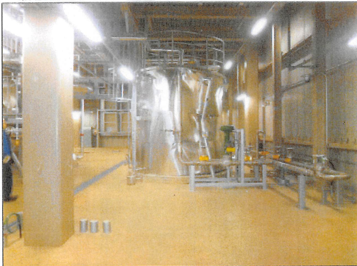
新設補助ボイラー建屋2階 損傷が確認されたタンク ⑮
