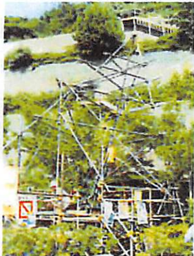
もんじゅ敷地内の地質を調べるために行われたボーリング調査の図解 準備作業=08年8月
