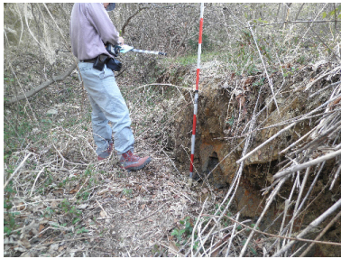
地震後に見つかった湯ノ岳断層の段差=土木研究所提供
