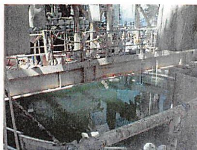
4号機原子炉建屋5階にある原子炉ウエル＝2011年6月29日に撮影され、翌30日に東電が公表した写真
