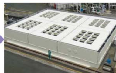
海水ピットポンプ室防護壁を設置 (飛来物対策後)
