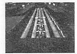
(陸側遮水壁海側 配管敷設状況)
