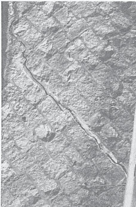
図23 地すべりに伴う開口亀裂 (兵庫県芦屋市) この亀裂は1995年兵庫県南部地震の際に、約2cm開口した。この開口部には、過去にセメントを充填して補修した形跡(白っぽい部分)が認められる。[池田撮影]
