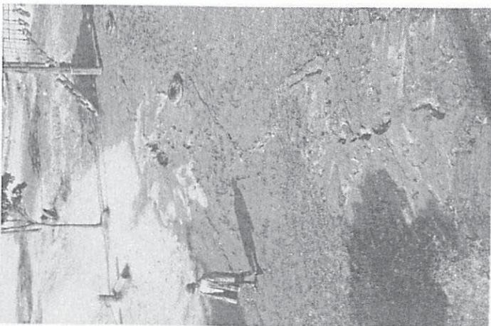
図25 海岸部に生じた噴砂の列(兵庫県芦屋市)
