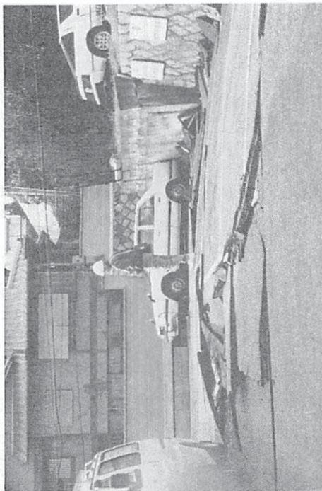
図22 地すべり地塊先端部に発達する圧縮性亀裂 (兵庫県西宮市) 写真右手の地すべり地塊が左に向かって移動し、その結果アスファルト舗装に圧縮亀裂が生じた。アスファルトの板の重なりから判断して、水平短縮量は1m以上ある。[池田撮影]
