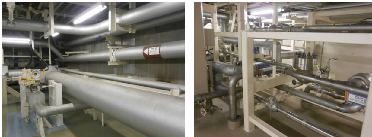
図1 本件発電所における配管の設置状況（一例）
