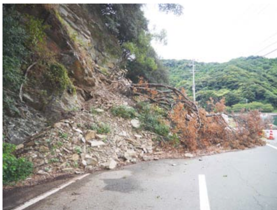
伊方町高浦の土砂崩れ現場
