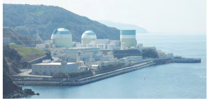
東側から見た伊方原発(左から3号機、2号機、1号機)
